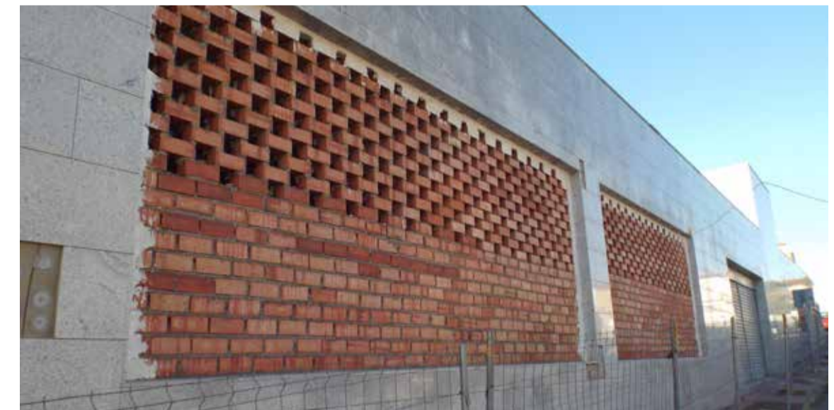
Situación actual del inmueble.
