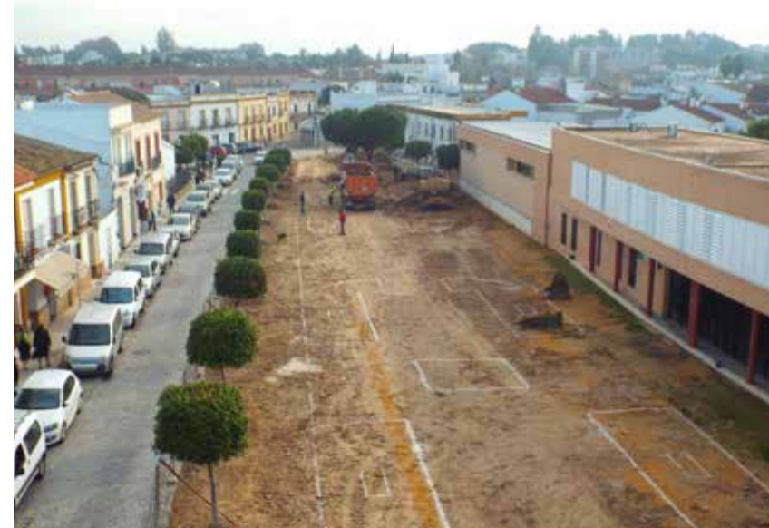
El paseo ganará enormemente en amplitud una vez terminadas las obras.
