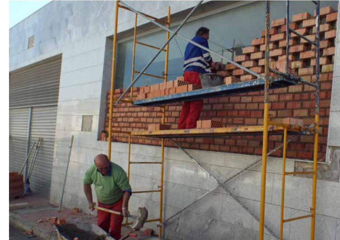
Operarios municipales tabicando las ventanas
