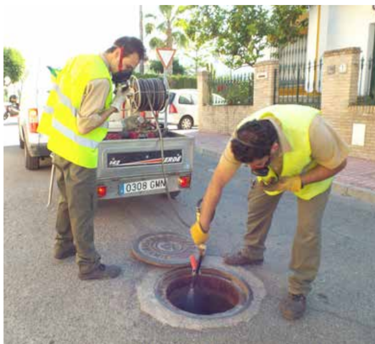
Operarios desinfectando el alcantarillado.
