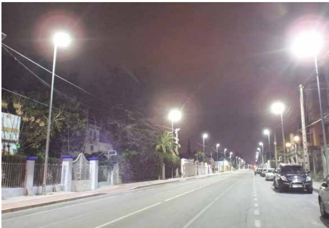
Aspecto de la Avenida de Europa con la nueva iluminación
